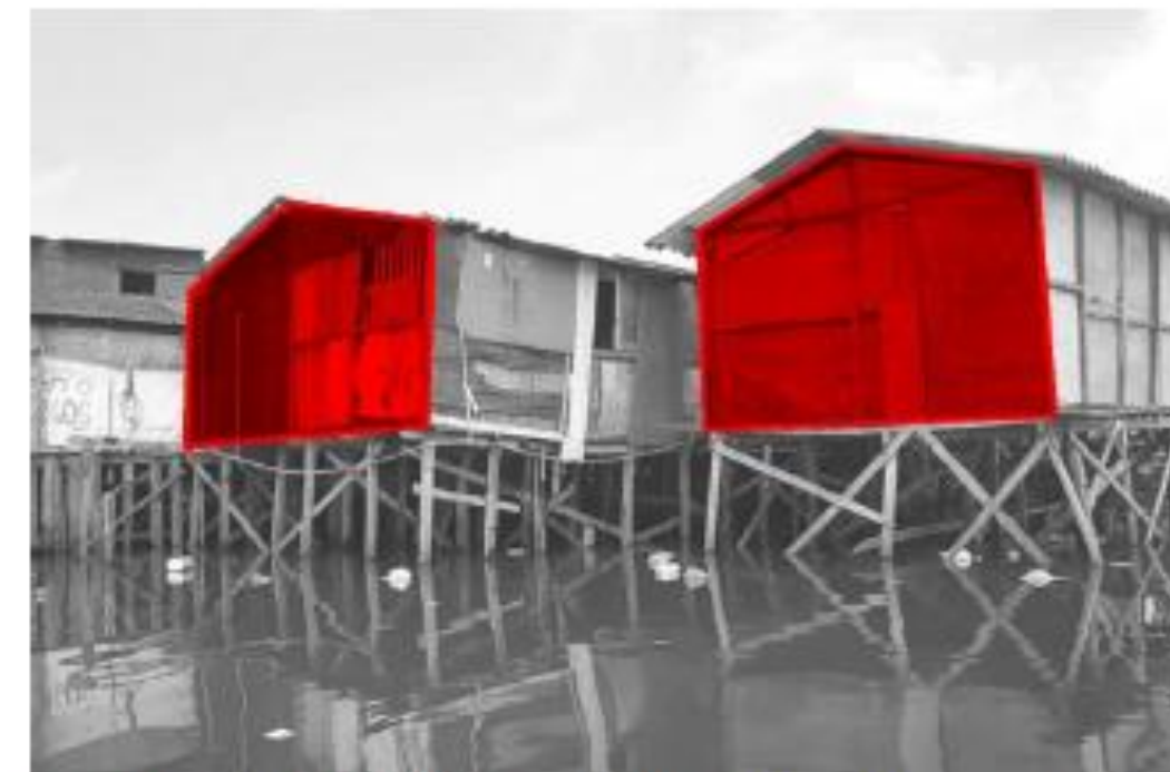
IDENTIFICAÇÃO DO ARQUÉTIPO DA ARQUITETURA - PALAFITA EXISTENTE
